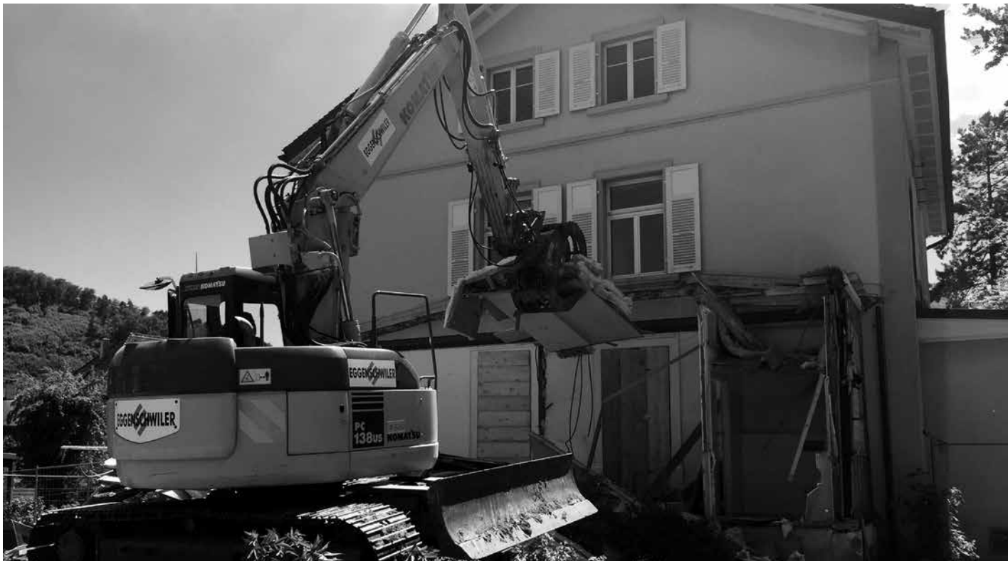
Abriss des alten Anbaus im Juni 2015
